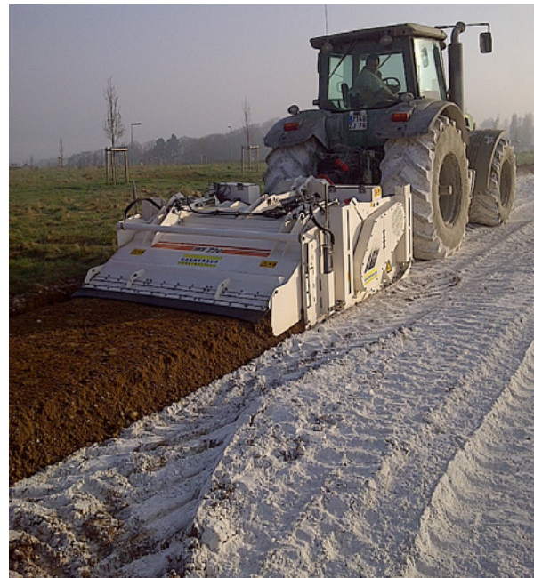
► Stabilisation à la chaux des limons
