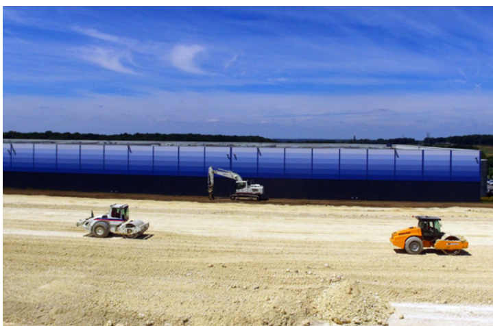
► Chantier de mise en œuvre de craie
