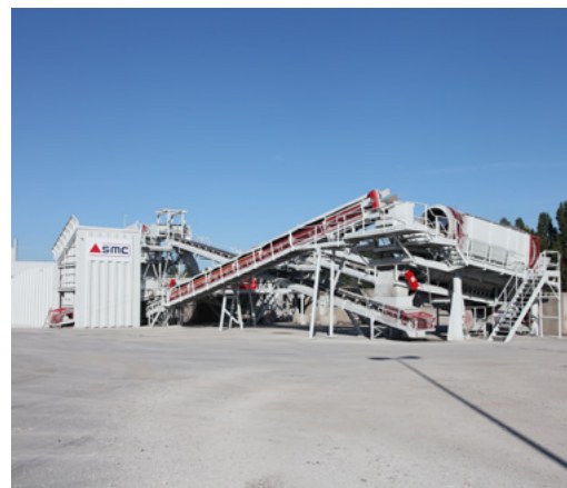
©Eurovia - Installation de traitement des mâchefers
