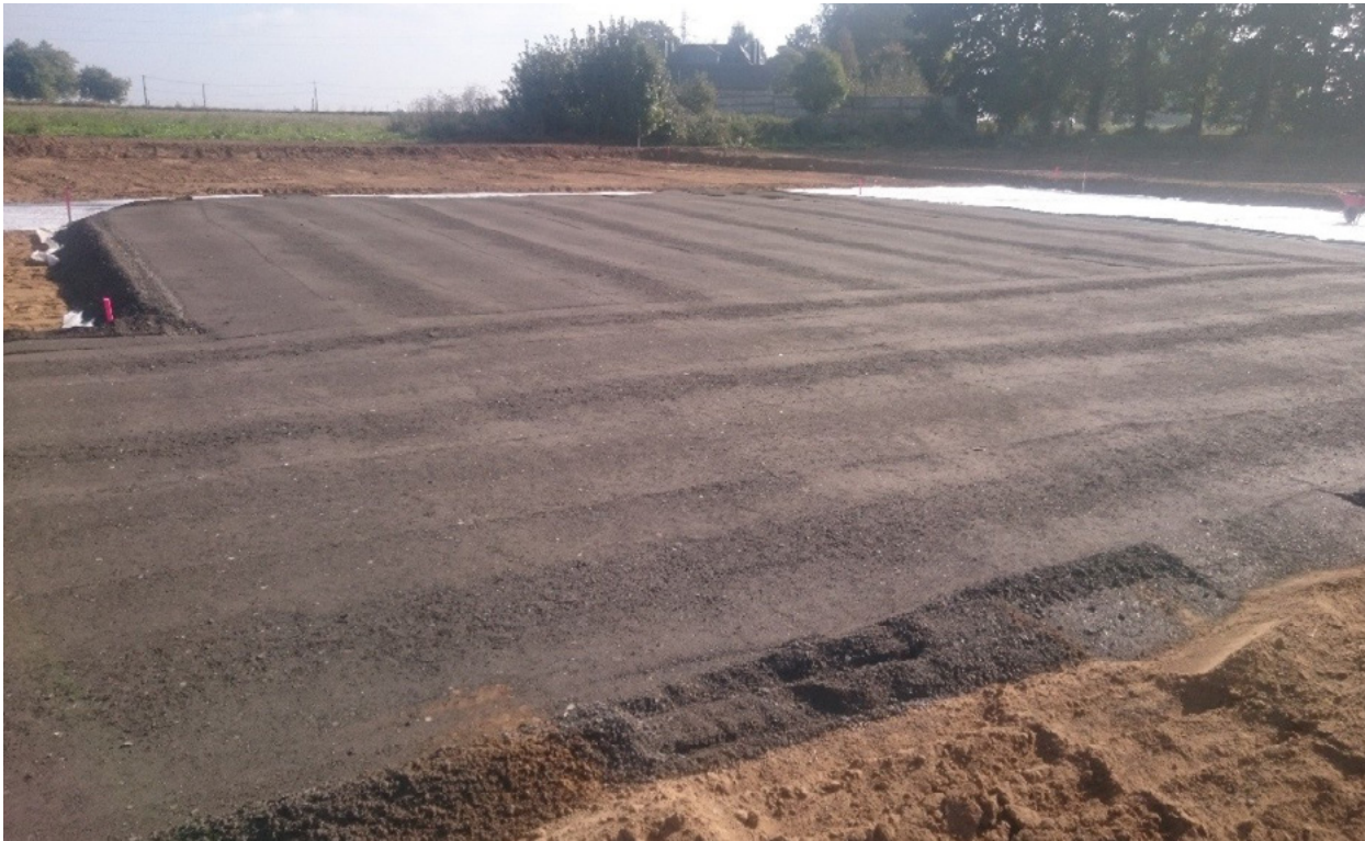
► Réalisation d'une plateforme en grave de mâchefer sur geotextile.
