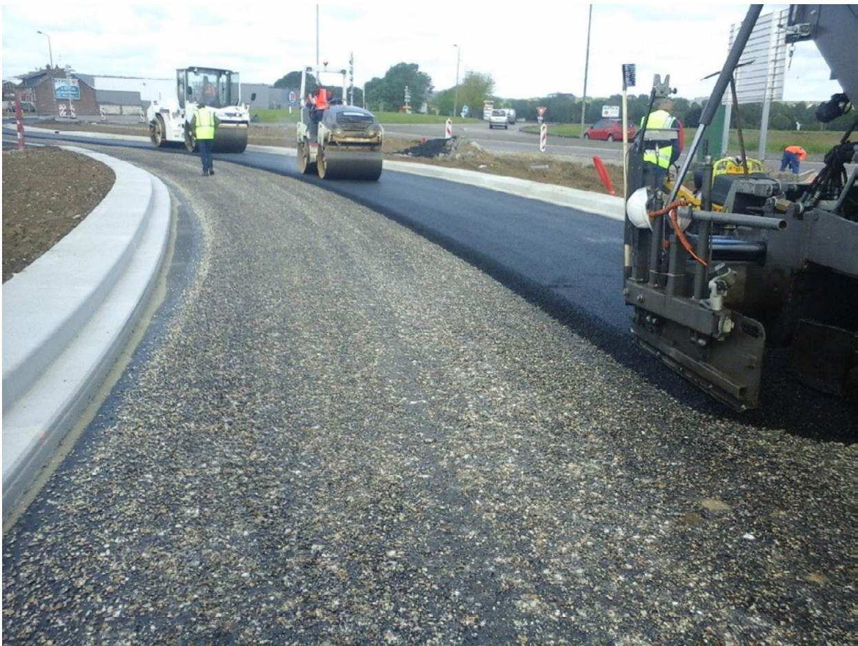
► Mise en œuvre d'enrobés à module élevé sur couche de forme en grave de mâchefer traitée aux liants hydrauliques.
