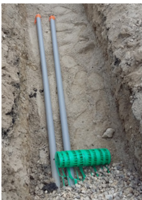
SABLES ET GRAVES UTILISÉS EN TRANCHÉES
