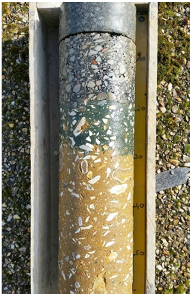
CAROTTE DE CHAUSSEE AVEC COUCHE DE FONDATION ELABOREE A PARTIR D'UN COPRODUIT
