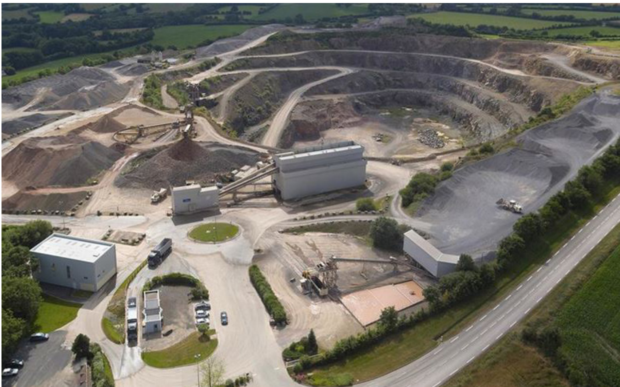
CARRIÈRE DE ROCHE MASSIVE
