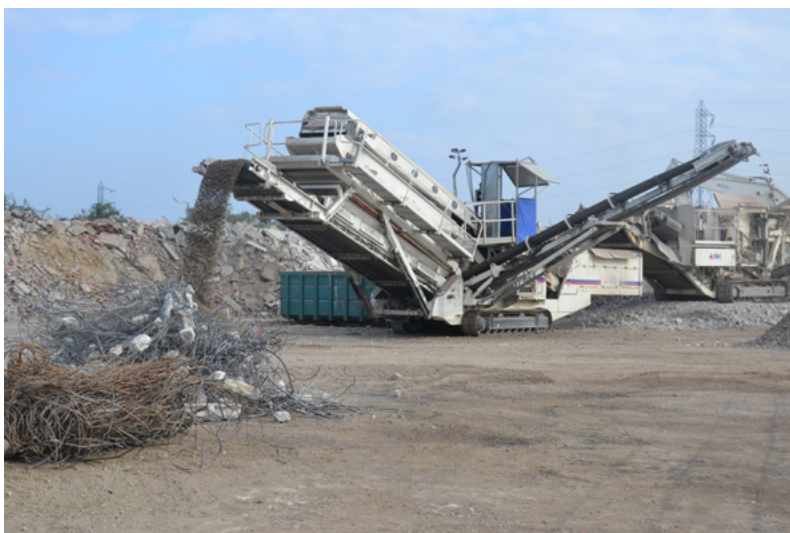
©Eurovia SMC : Concassage criblage des poteaux béton déposés - Calvados
